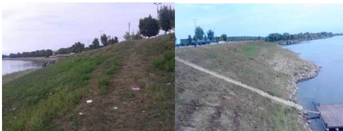
Slika 2.2 Predmetna lokacija – pogled uzvodno i nizvodno
